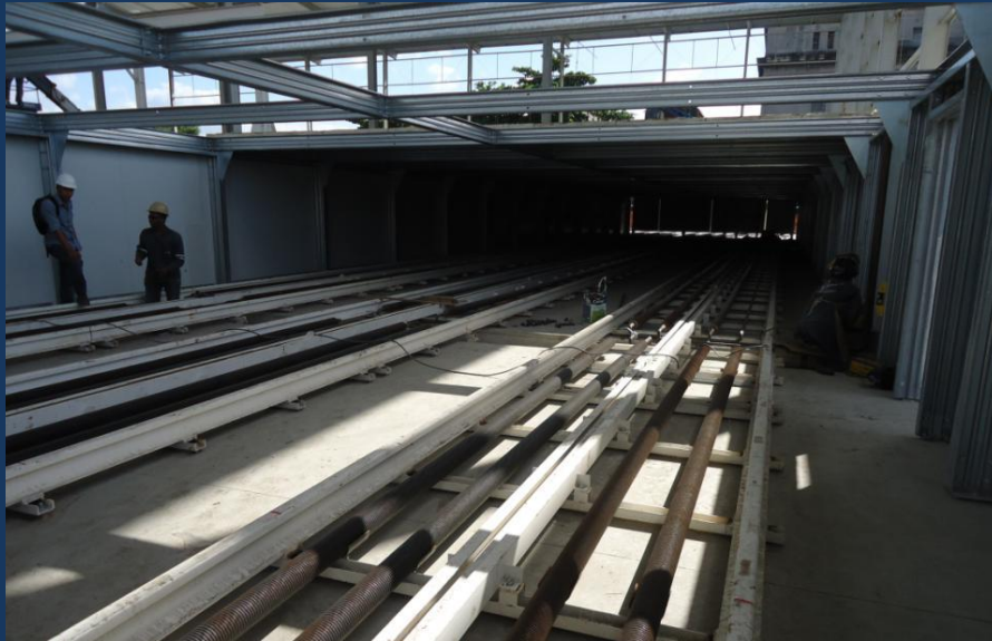
Montagem do túnel de cura e trocadores de calor.
