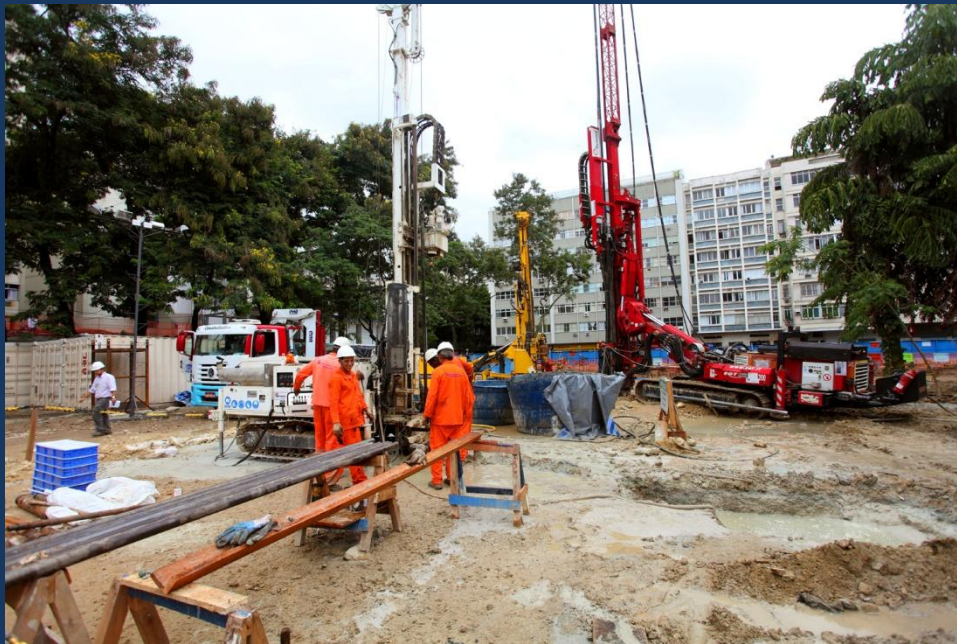
Início da impermeabilização do solo na Antero de Quental
