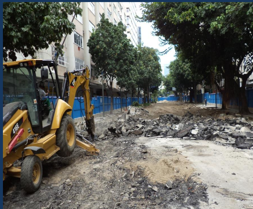
Remoção Pavimento Ataulfo de Paiva
