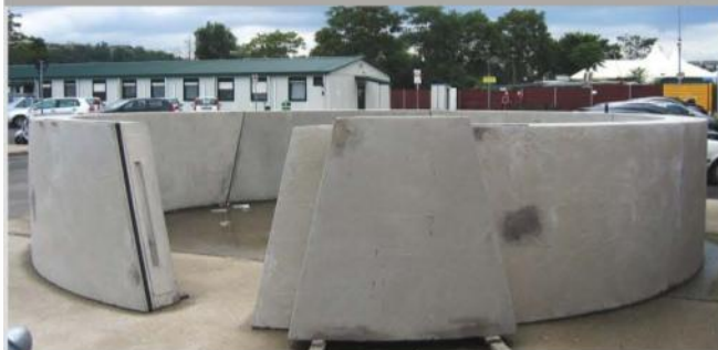
4. Anello in c.a. prefabbricato posato a terra in cantiere
