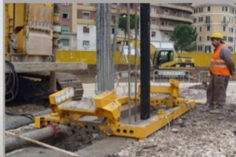
6 - 7. Particolari dell'attrezzatura di scavo della macchina, inserita tra i cordoli guida, in fase di escavazione
