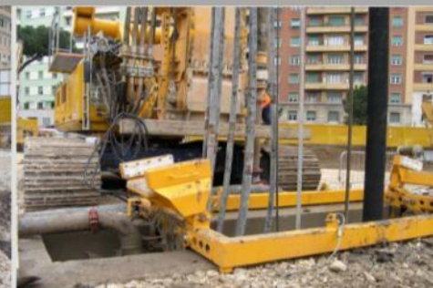
6 - 7. Particolari dell'attrezzatura di scavo della macchina, inserita tra i cordoli guida, in fase di escavazione
