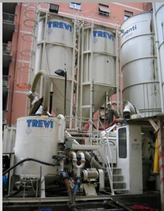
7-8-9. Area di confezionamento della miscela di iniezione
