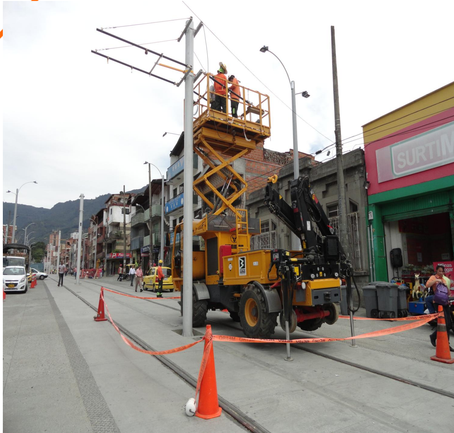
Montaje de catenaria a cargo de personal Metro, en la Calle 49 (Ayacucho) entre las Carreras 31 y 33)
