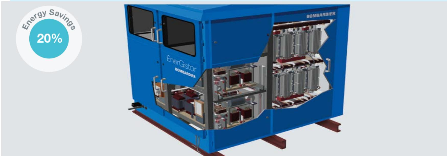
Basado en tecnología de supercapacitores que capturan y almacenan energía que podría perderse en el proceso de frenado y la recicla dentro del sistema.
