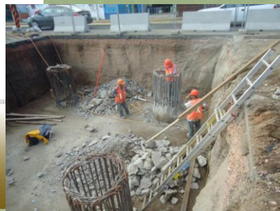
Fase 4 Excavación de Zapata y Descabece de Pilas
