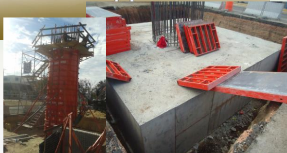
Fase 5 Colado de Zapata y Columna
