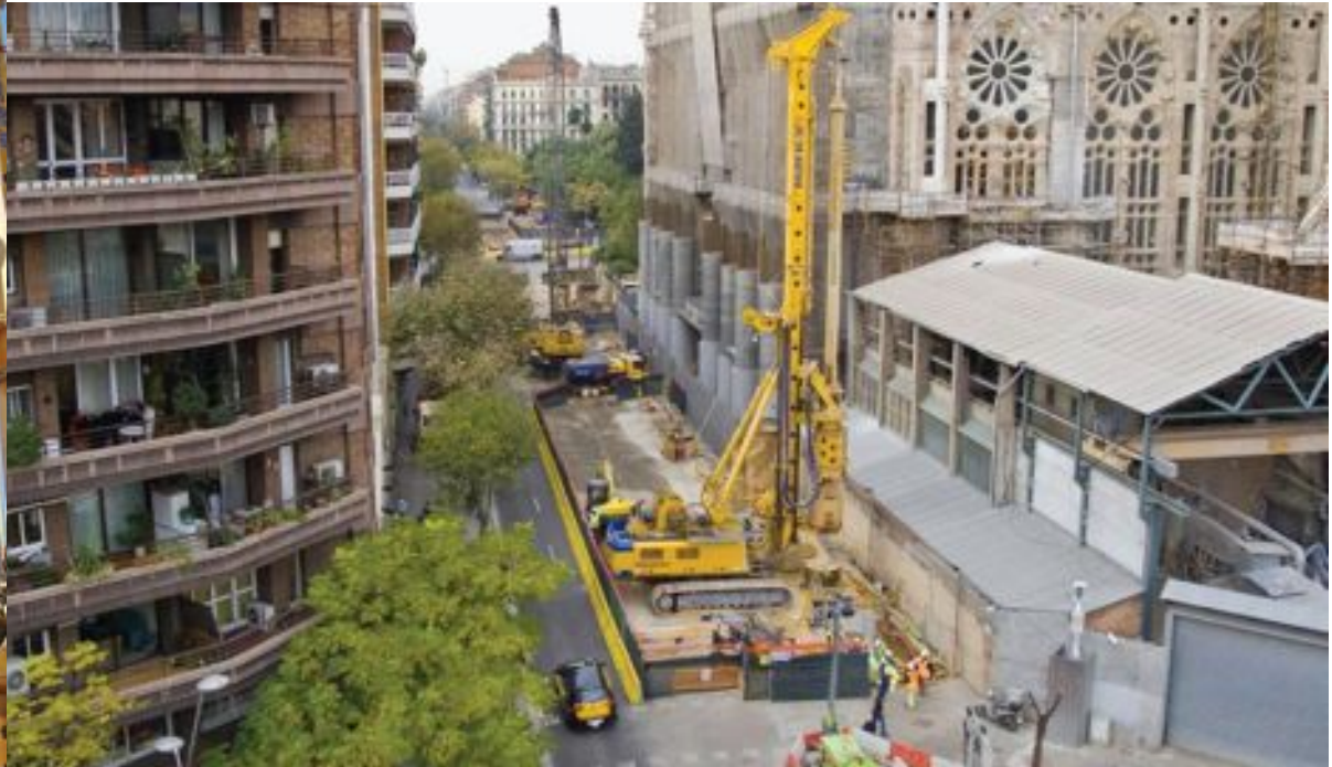
Ejecución de la barrera de pilotes
