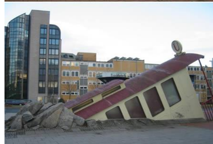
Estación de Metro Bockenheimer, en Frankfurt
