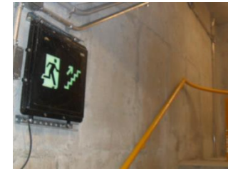
Señalización de Salidas de Emergencia retro alumbradas
