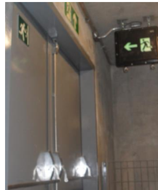
Señalización de Salidas de Emergencia retro alumbradas
