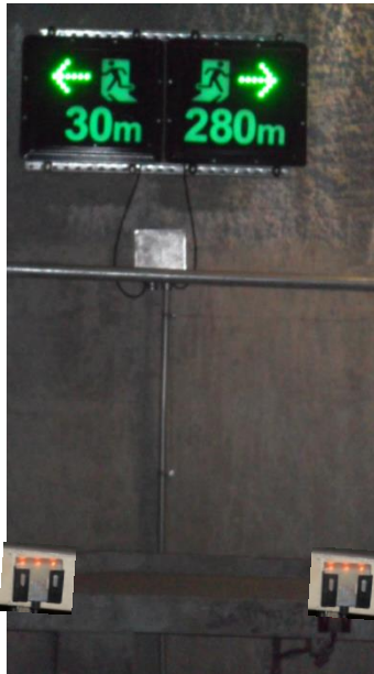
Señal de sentido y distancia y balizadores de borda en las pasarelas (retro alumbradas)
