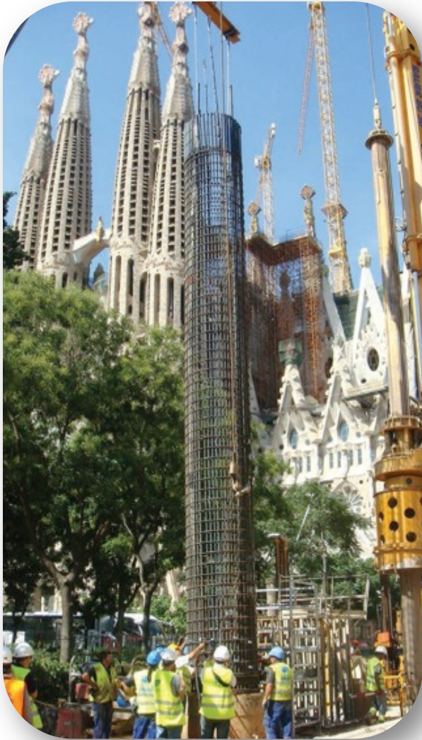
Ejecución de la barrera de pilotes
