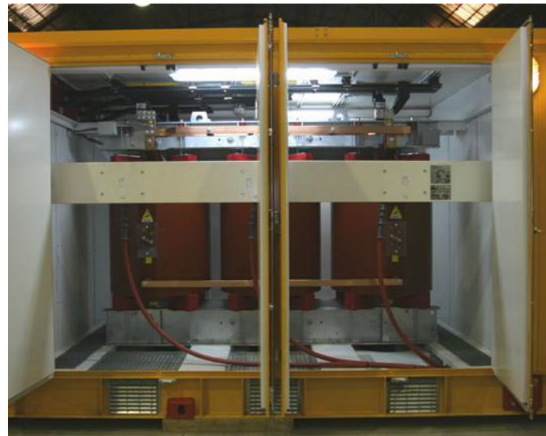
Compartimento Trafo Tracción
