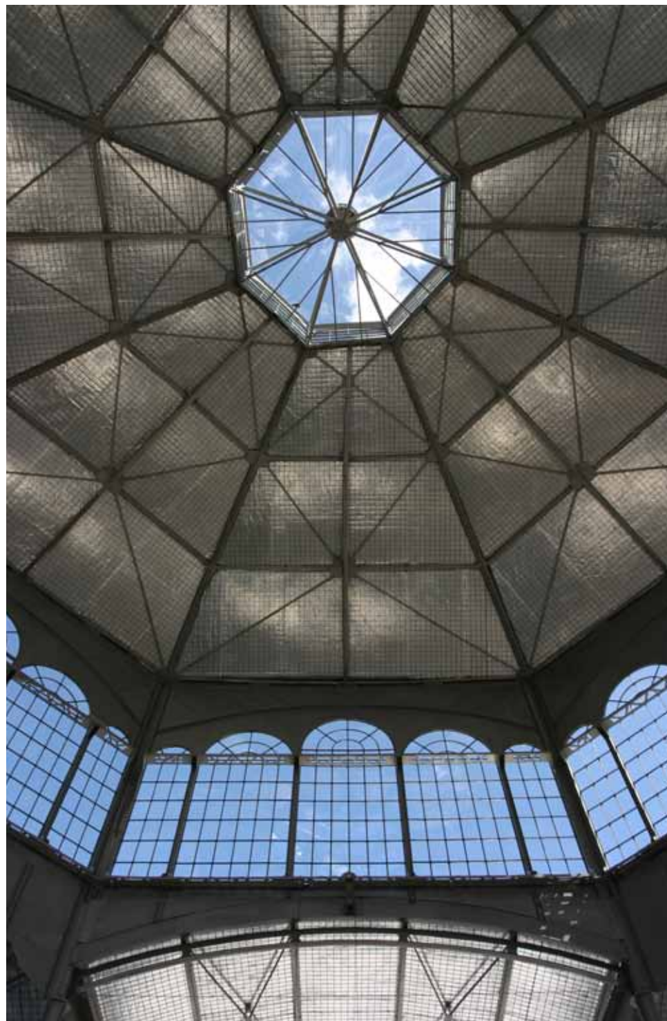
Linterna de la cúpula del Centro de Cultural Itchimbí
