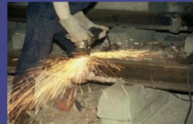
Em 1965 compraram-se os primeiros carris com uma dureza de 90 Kg/mm<sup>2</sup>, para aplicar exclusivamente em zonas de curvas. Os carris normalmente utilizados tinham uma dureza de 70 Kg/mm<sup>2</sup>.
