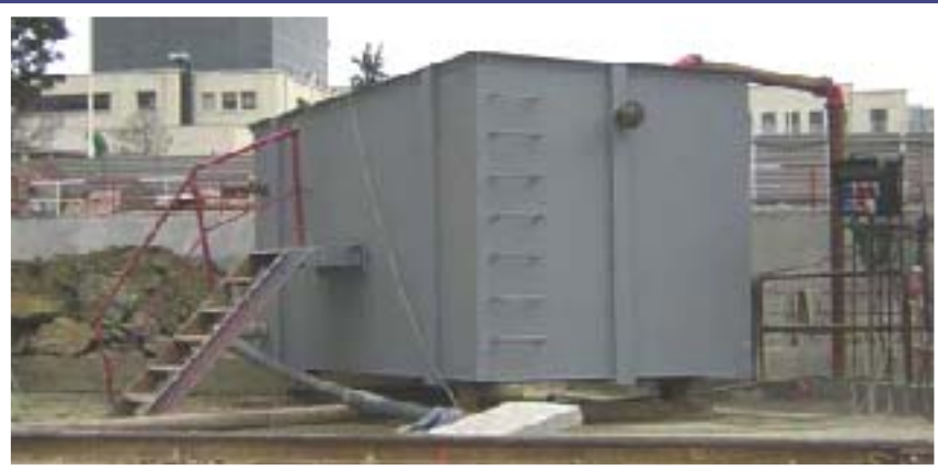
Decantador associado a sistema de lavagem de rodados
