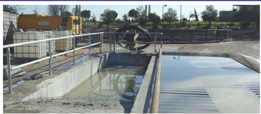
Decantador associado a sistema de lavagem de rodados
