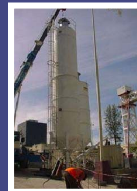
Colocação de filtros em silos
