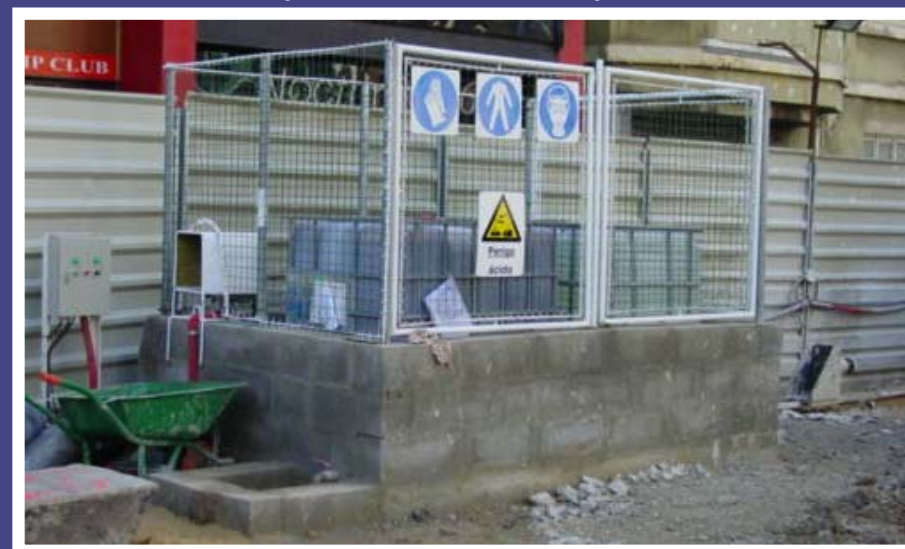
Sistema de doseamento de ácido para controlo do pH
