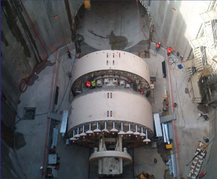
Montagem da Tuneladora
