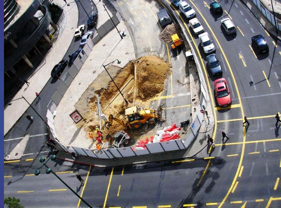
Sondagens de redes na zona da laje de cobertura do acesso ao El Corte Inglés
