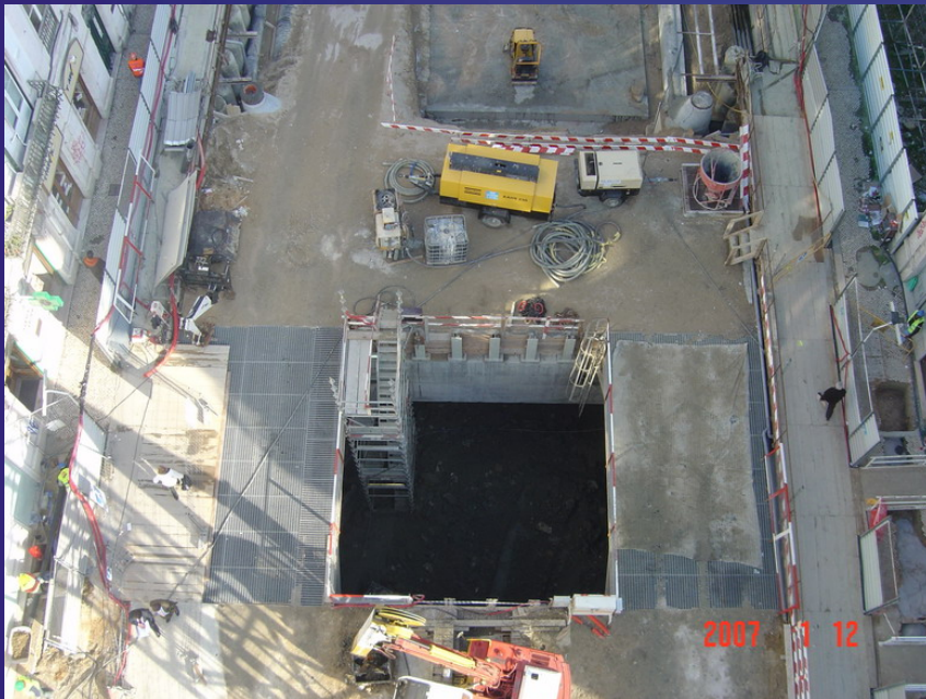
Abertura na Laje de Cobertura para a retirada do material de escavação
