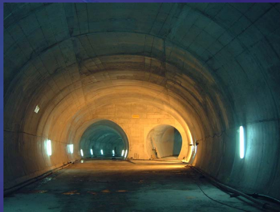
Túnel executado pelo método NATM
