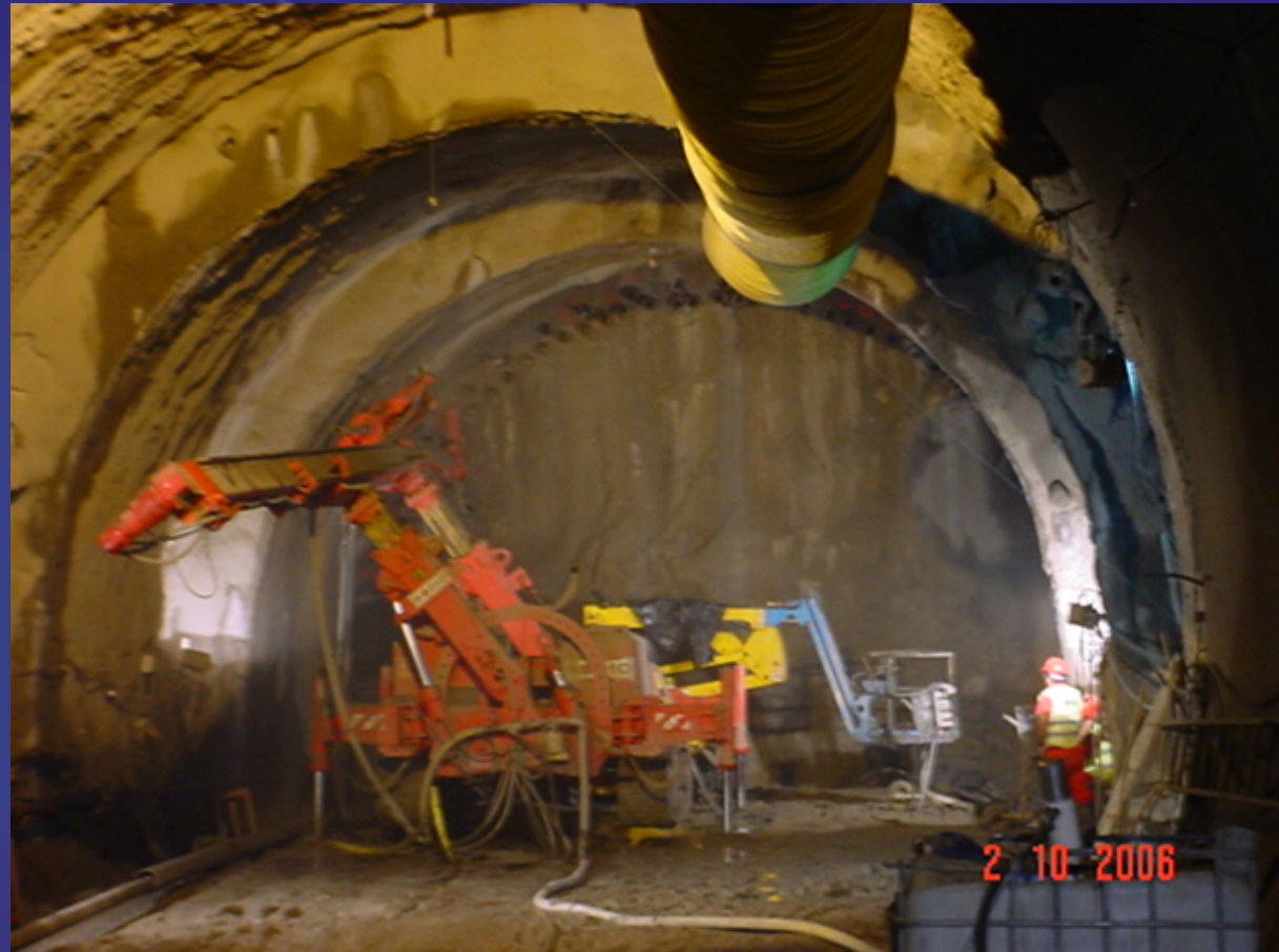
Execução do túnel através de câmaras cónicas
