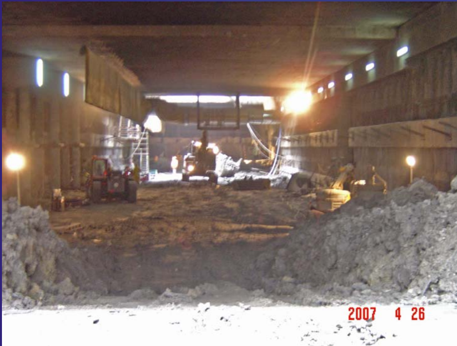
Escavação sob a Laje de Cobertura e reposição à superfície
