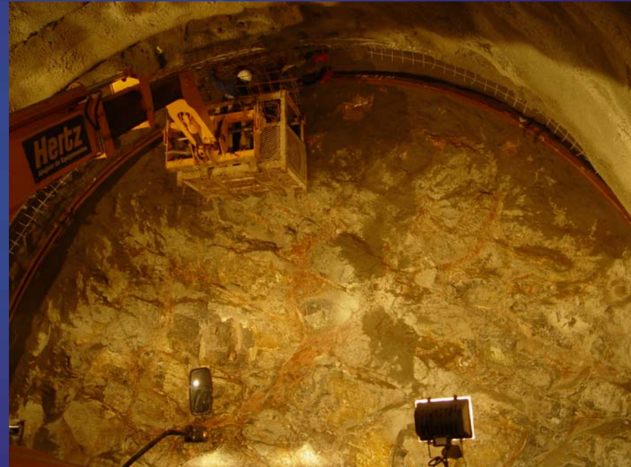
Colocação da Cambota Metálica
