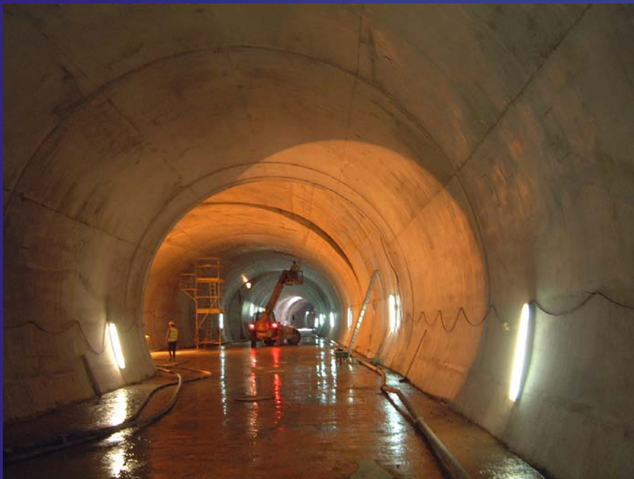
Túnel executado pelo método NATM
