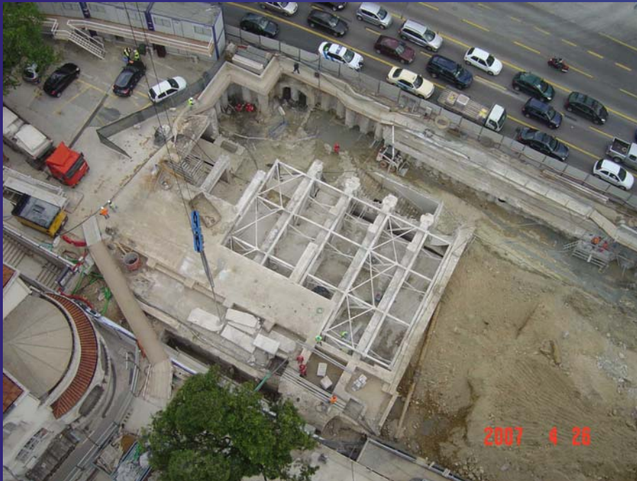
Demolição Parcial do Átrio Norte da Estação Saldanha I
