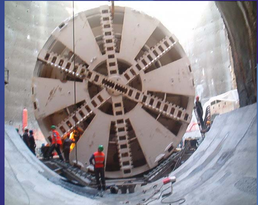
Colocação da Tuneladora no Túnel Piloto
