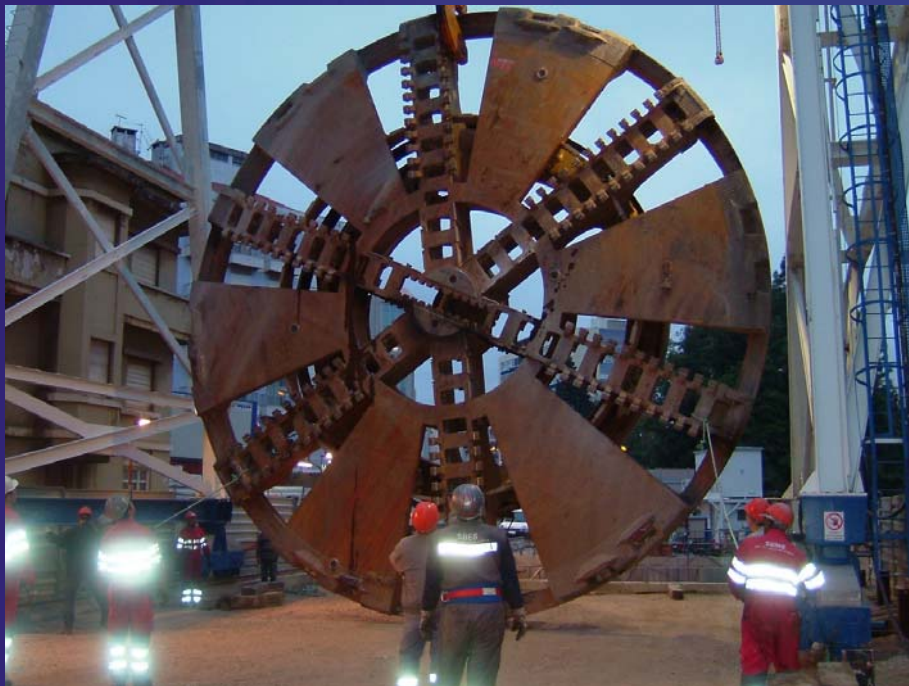
Retirada da Tuneladora pelo Poço Nascente
