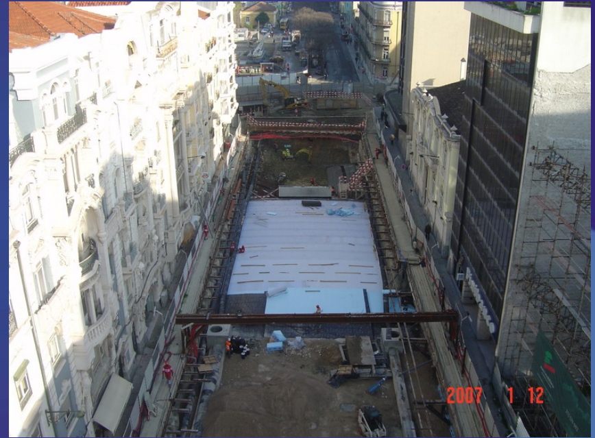
Impermeabilização da Laje de Cobertura
