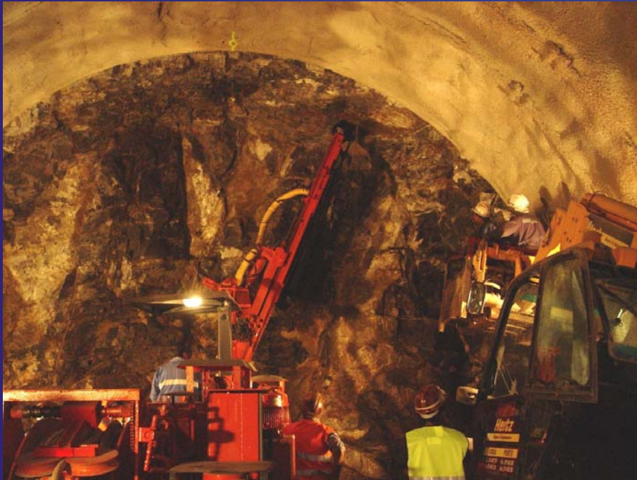
Execução dos Tratamentos de Jet Grouting
