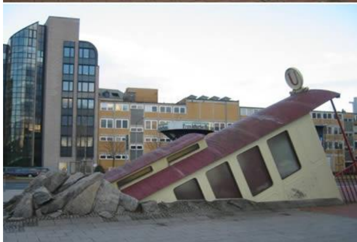
Estación de Metro Bockenheimer, en Frankfurt
