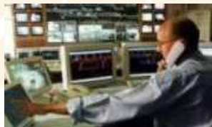
EBI* Screen Puesto de Control Central
