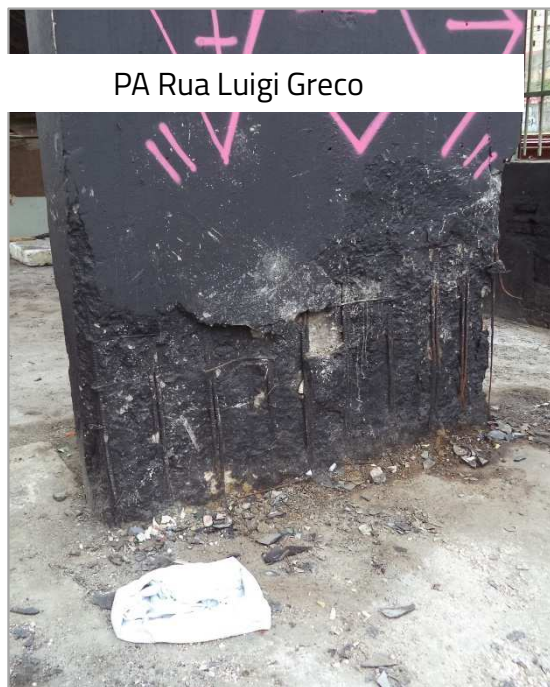
Recuperação estrutural das bases dos pilares com equipe interna e posterior reabilitação da passarela
