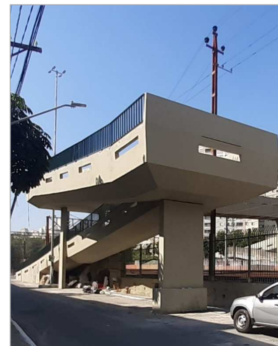
Recuperação estrutural das bases dos pilares com equipe interna e posterior reabilitação da passarela
