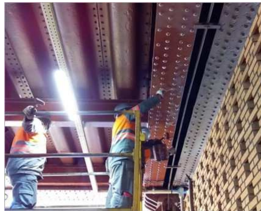
Recuperação estrutural das vigas metálicas
