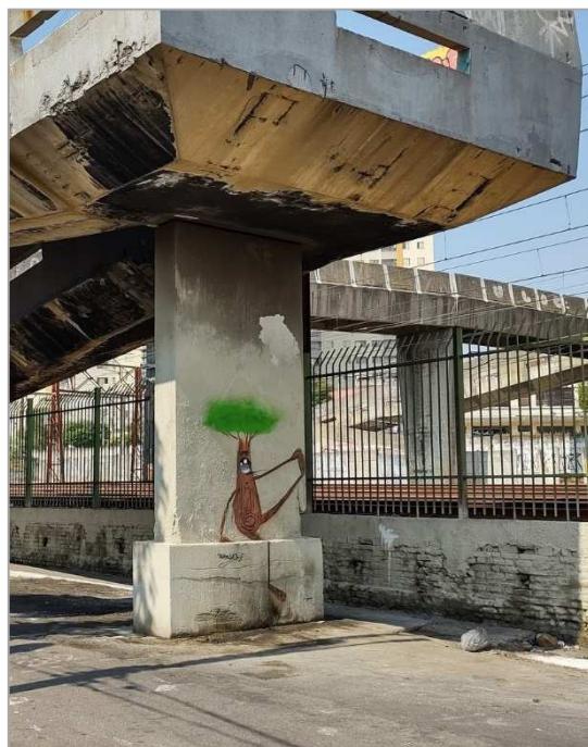
Recuperação estrutural das bases dos pilares com equipe interna e posterior reabilitação da passarela
