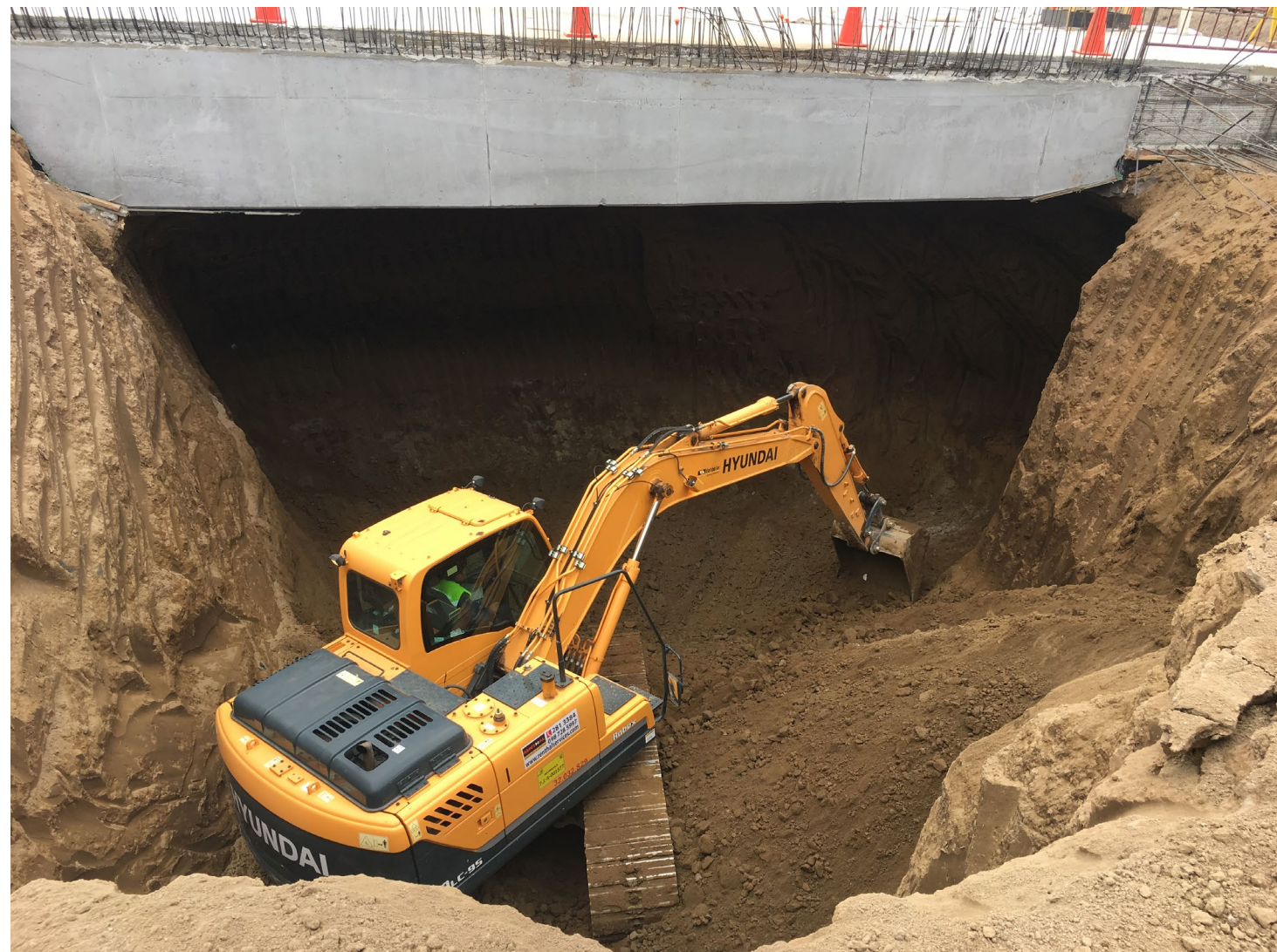
Excavación de Niveles Inferiores
