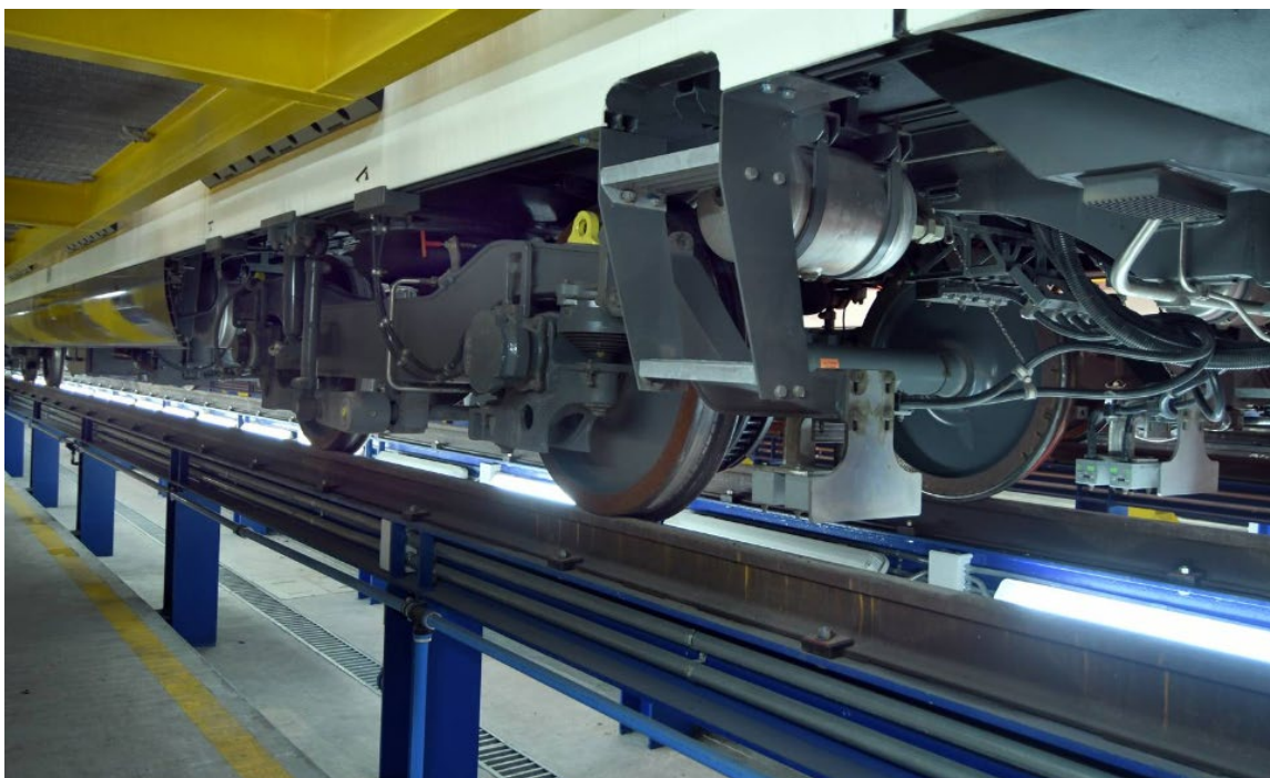
Vía de mantenimiento sobre pilaretes metálicos
