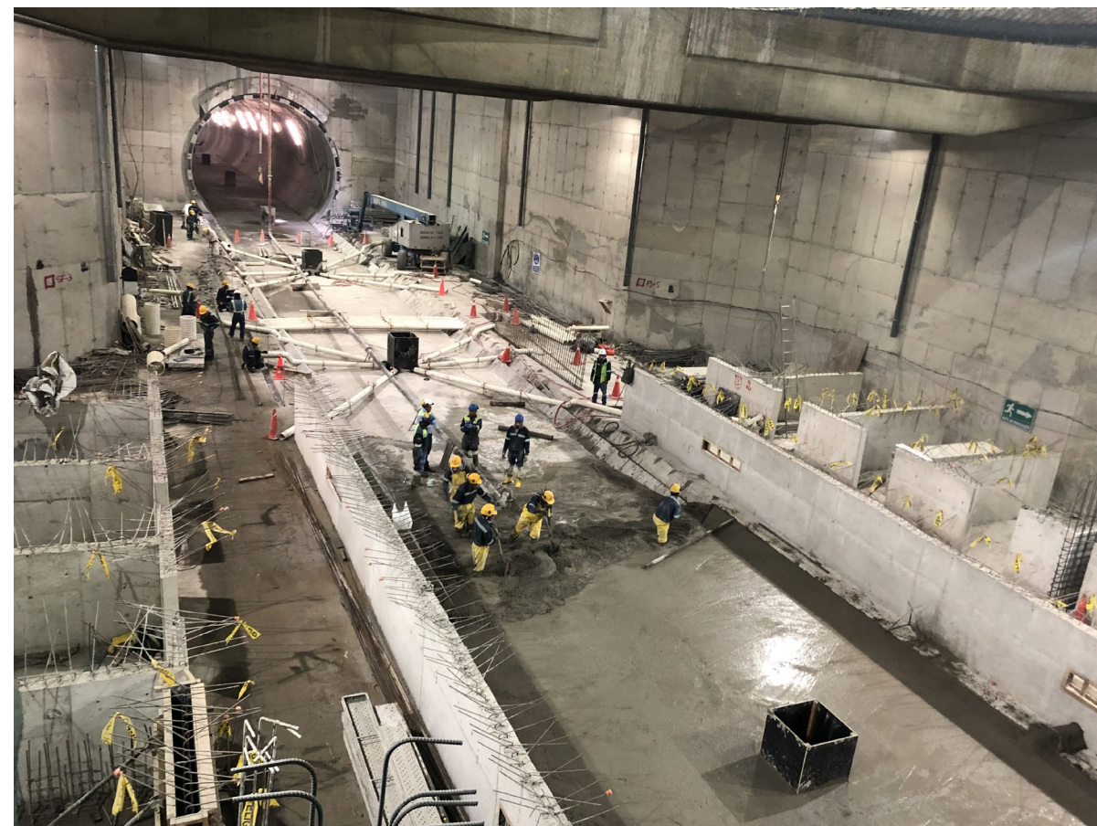
Relleno hasta cota inferior de superestructura
