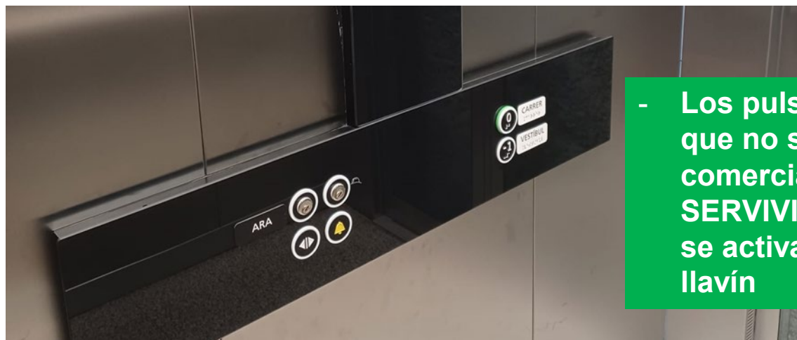
Botonera ascensor vestíbulo y ARA de estación de Amado Granell Montolivét. Metrovalencia
