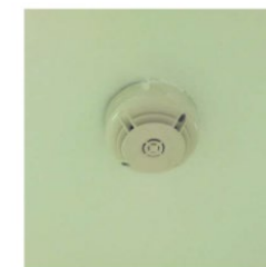
d) Detector óptico contraincendios de humo
