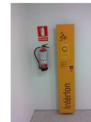
a) Interfono de comunicación y extintor de polvo ABC
