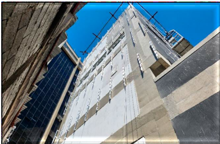
Novo Edifício Técnico Operacional (ETO): Montagem do brise da fachada.
