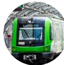
Metro de Lima Línea 1
